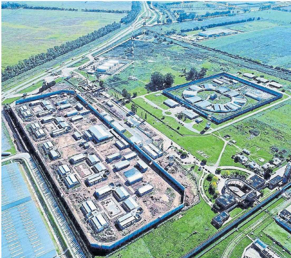
En Campana, junto a la Unidad 41, se está terminando de construir una cárcel "modelo" para jóvenes reclusos
