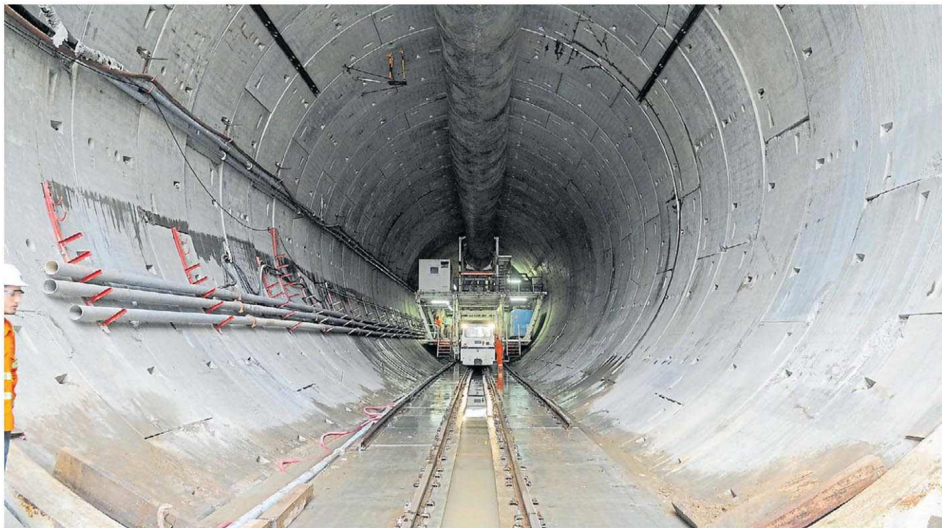
Por dentro. La obra del soterramiento del tren Sarmiento, en pleno proceso. El Gobierno busca sacar a la constructora investigada en el país por el pago de coimas. NÉSTOR GARCÍA
