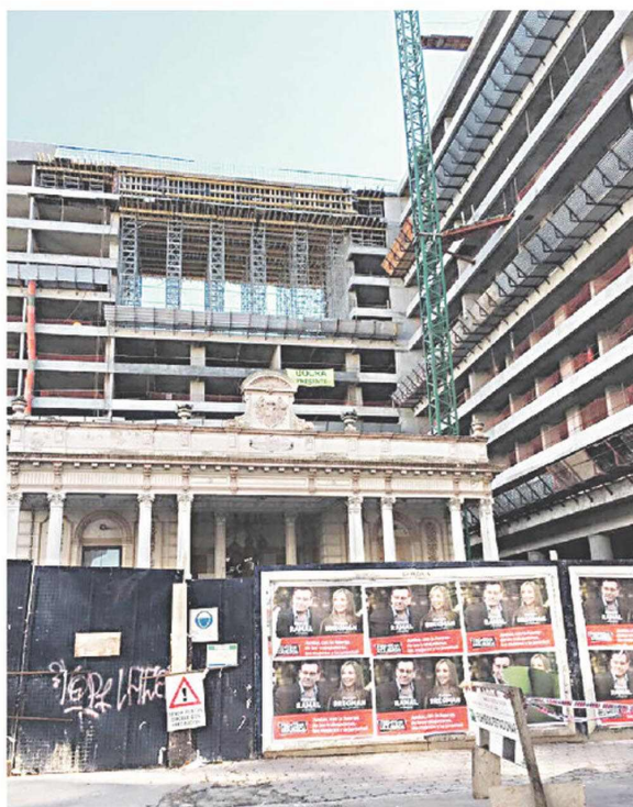
IRREGULAR. Las torres, paralizadas, en torno al Palacio Roccatagliata en el barrio porteño de Coghlan.
