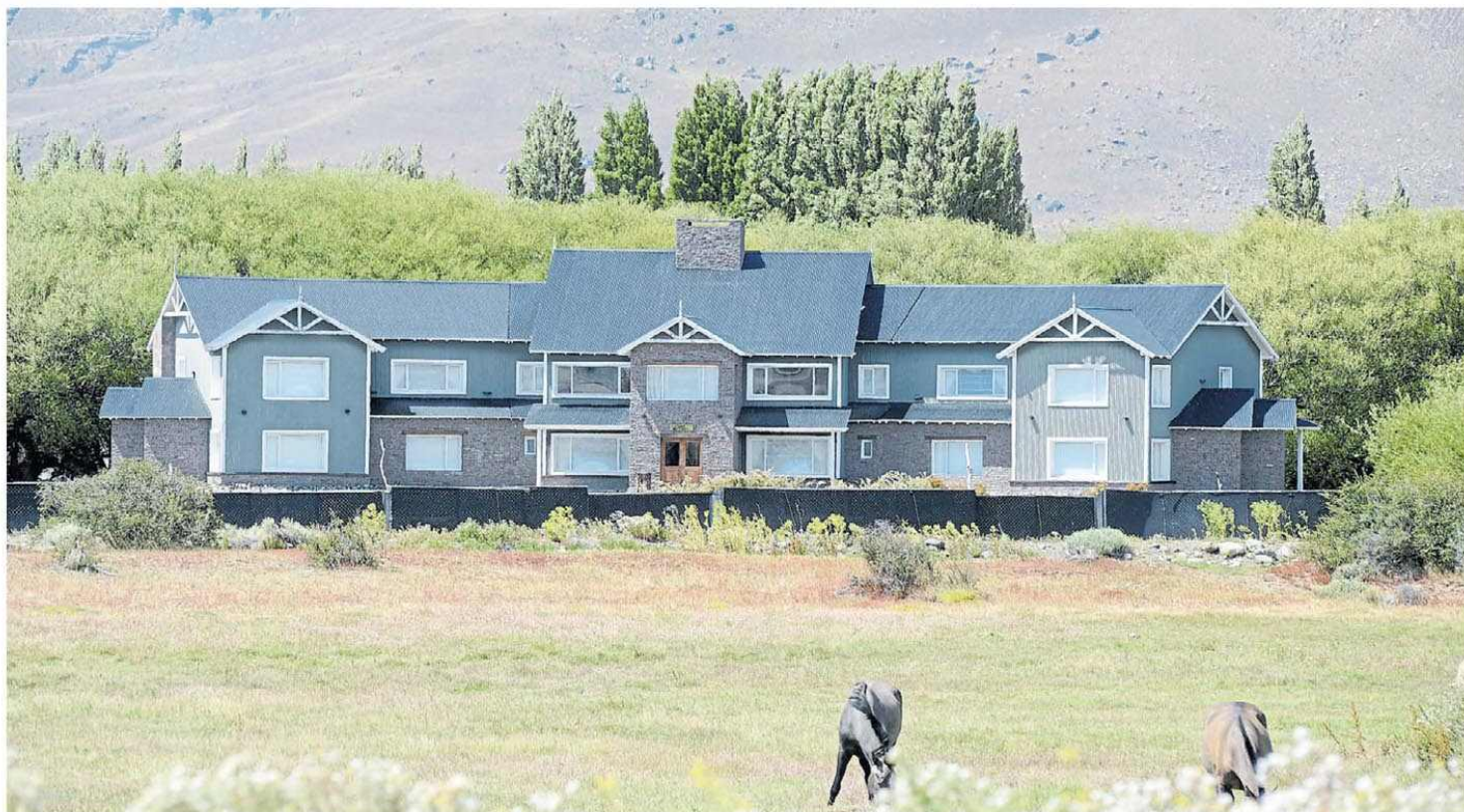
Los Sauces. El hotel boutique que los Kirchner construyeron en El Calafate y por el que recibieron millones. Hoy está cerrado y en estado de abandono.
